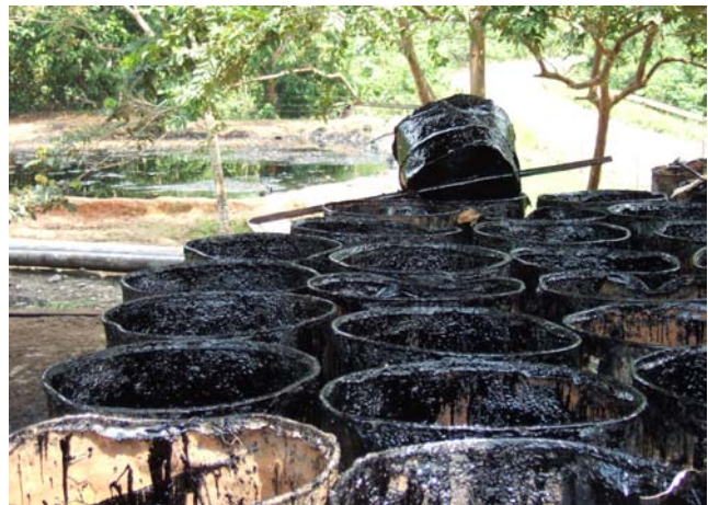
Ölfässer und ein nicht abgedichteter Ölsee „pozo“ (15x10m) bei einer Förderstation von Petroecuador (La Yuca)
