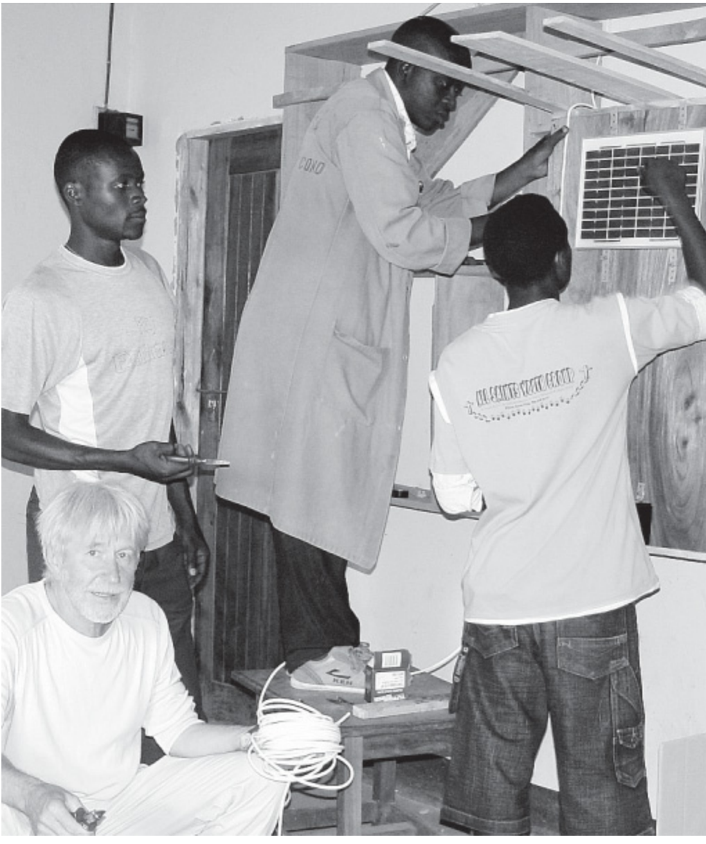
Beim Aufbau der Demonstrationsanlage: Ulrich Lasar mit dem Elektriker aus Rukungiri (Zweiter von rechts) und zwei Dorfbewohnern.
