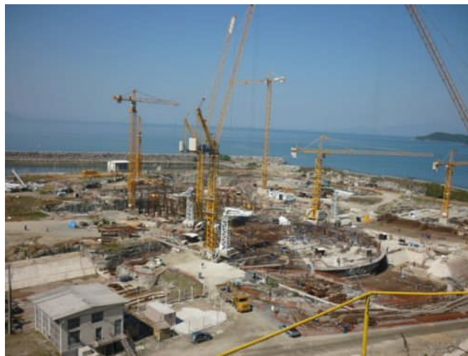
die Baustelle des Reaktors Angra 3, August 2010
